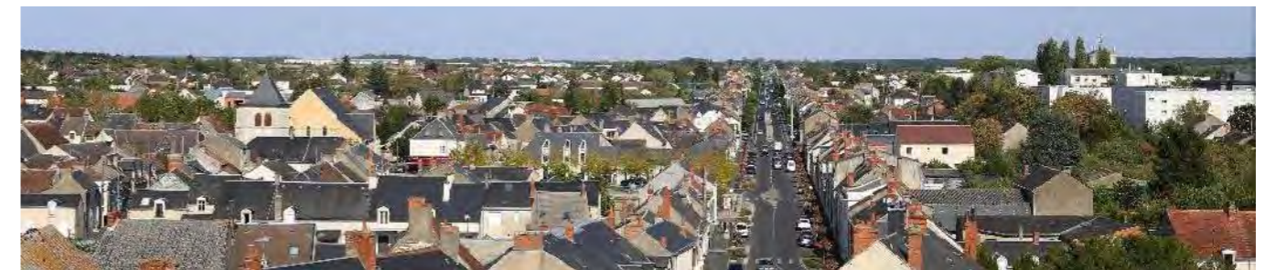
Photo 124 : La densité bâtie ne permet pas de perception lointaine depuis le cœur urbain de Châteauroux
