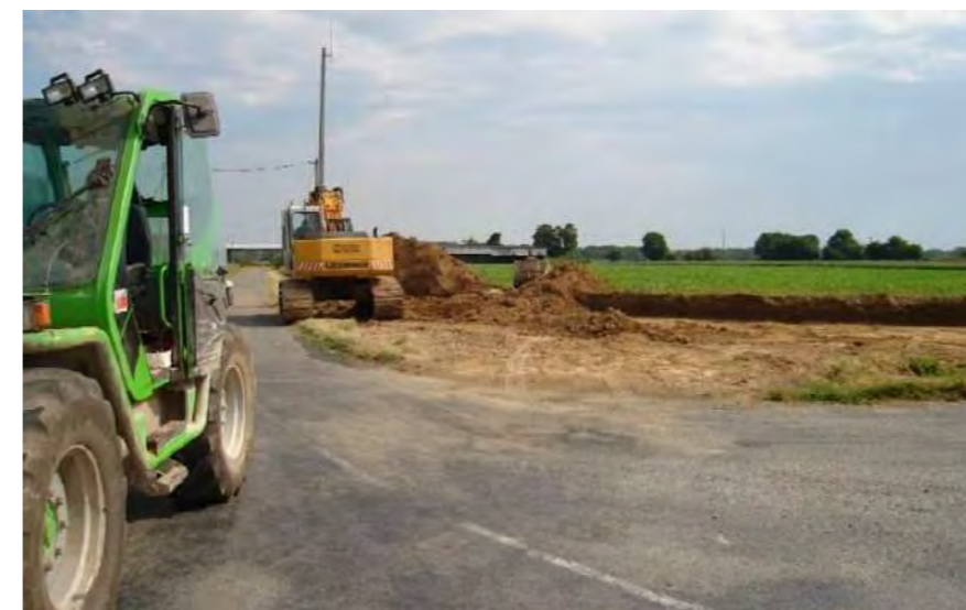
Photo 159 : les travaux de rectification d'un virage
