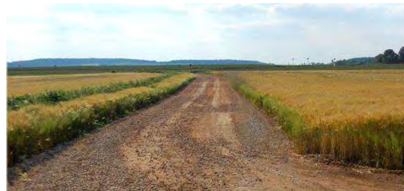
Photo 142 : un exemple de voie d'accès à un parc éolien en milieu agricole
