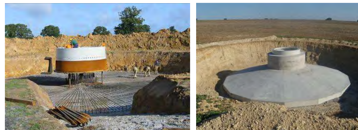
Photo 140 : Le ferrailage et le coulage d'une fondation d'éolienne
