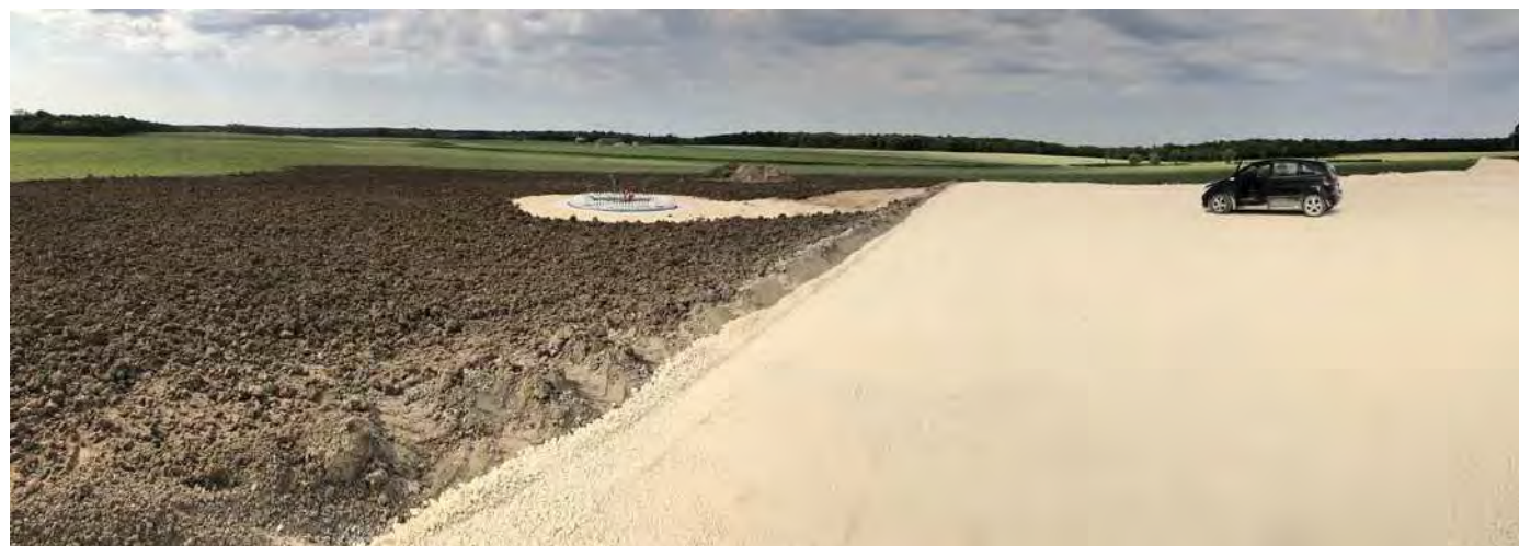
Photo 141 : un exemple d'aire de grutage depuis le pied d'une éolienne
