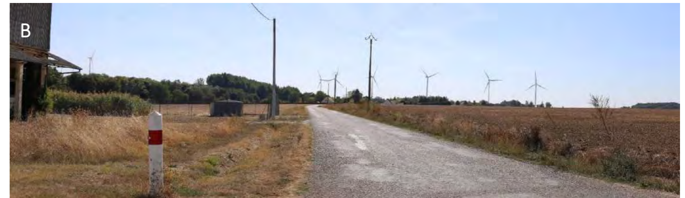
Photo 67 : Les parcs éoliens de Vouillon et La Champagne Berrichonne sont déjà visibles depuis l'entrée de bourg au nord de Vouillon. La zone de projet est située en arrière-plan du parc éolien de Vouillon
