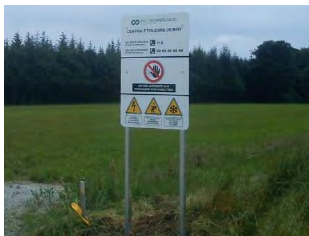
Figure 129 : un exemple de panneau de prévention des risques sur un parc éolien
