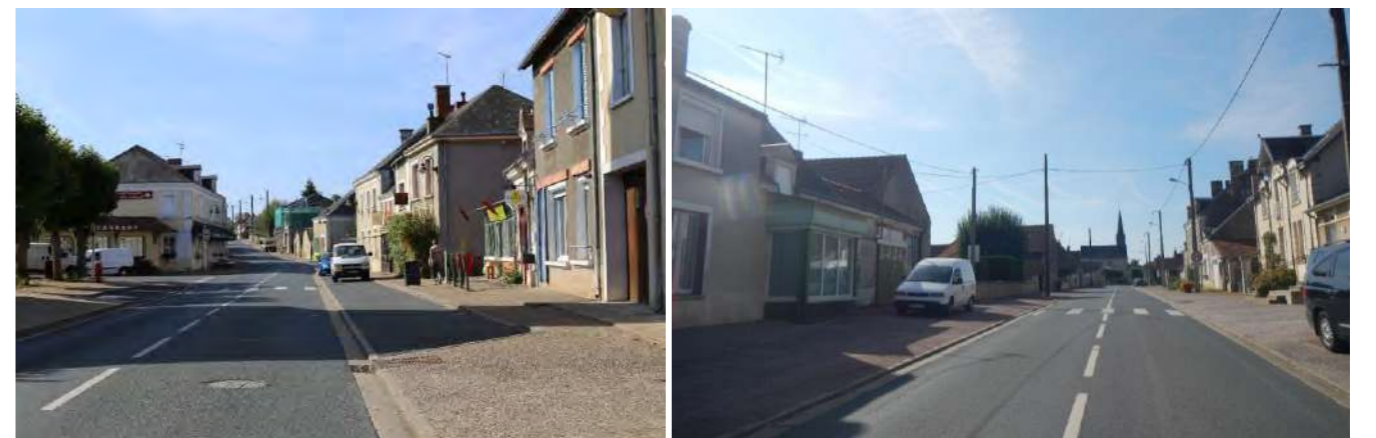
Photo 65 : Depuis la route principale du bourg (RD918) les vues latérales sur la zone de projet sont souvent très contraintes par la présence du bâti
