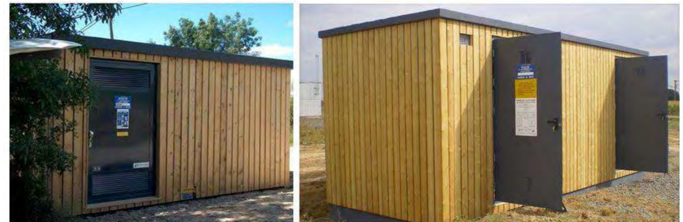
Figure 153 : Modèle choisi pour les postes de livraison : bardage bois et teinte grise (RAL 7016) pour les parties métalliques
